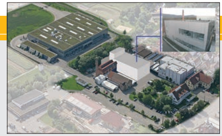
Das Firmengelände der Lechler GmbH in Metzingen. In der Mitte das derzeit im Bau befindliche Technikumgebäude.
